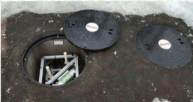
NTTドコモのマンホール型基地局。深さ70cmの穴に設置するが、アンテナの先端と地表まで10cmしか離れていない。
